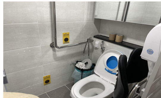
▲ 공사 이후 바뀐 모두를 위한 화장실
