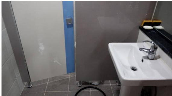
▲ 공사 전 도서관 남자 화장실
